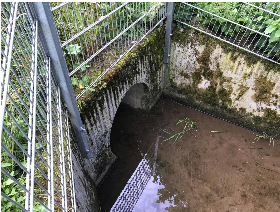
Abb. 4 Einleitstelle des Hochwasserablaufs DN 900
