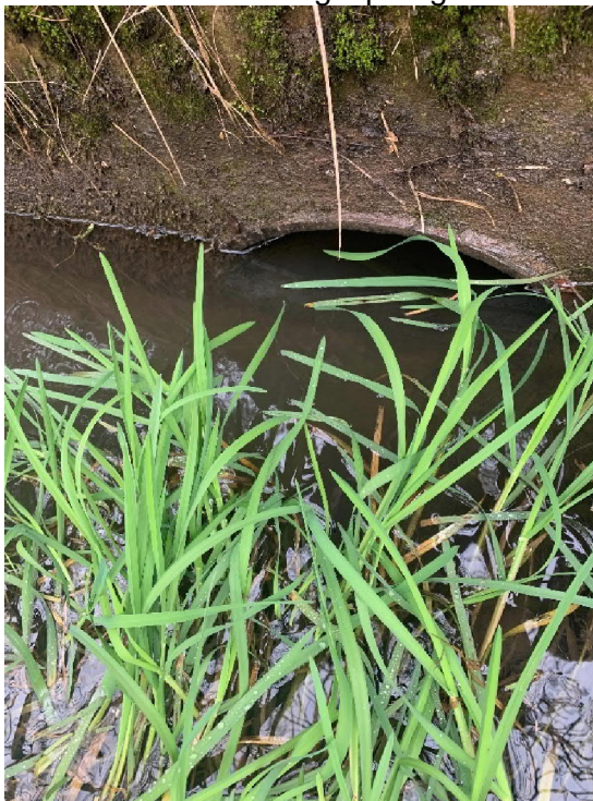
Abb. 3 Einleitstelle des Normalablaufes DN 200
