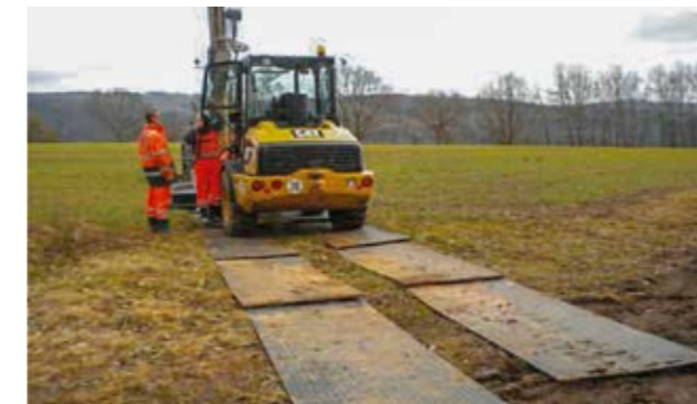
Einsatz von Bodenschutzplatten
